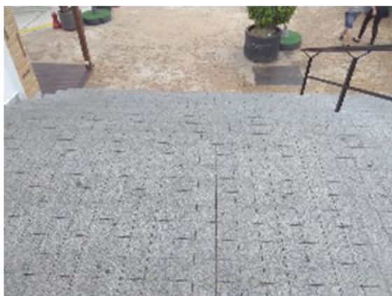
Foto izq.: Escalera de acceso a la playa, sin contraste cromático entre huella y contrahuella
