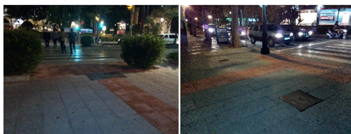
Foto: Vado rebajado con franja de pavimento podo-táctil de botones en lugar de franja de pavimento direccional.
