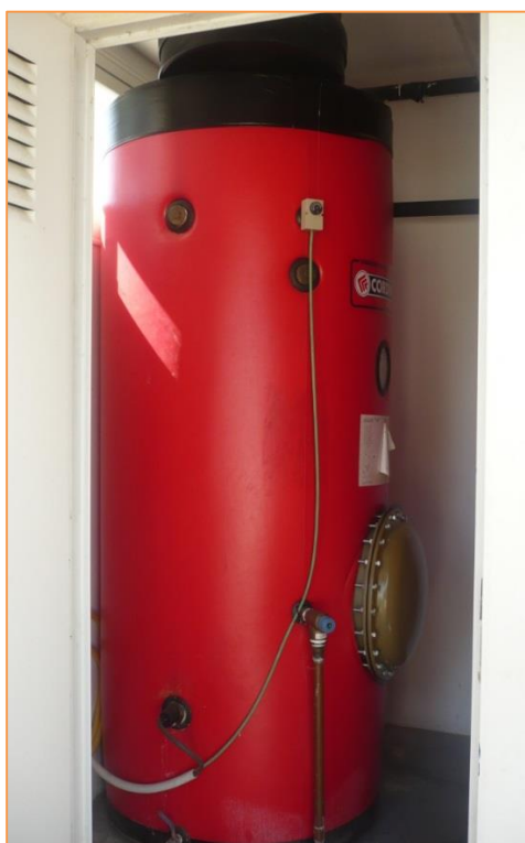
Imagen 14 Termos acumuladores eléctricos. Sala de termos
