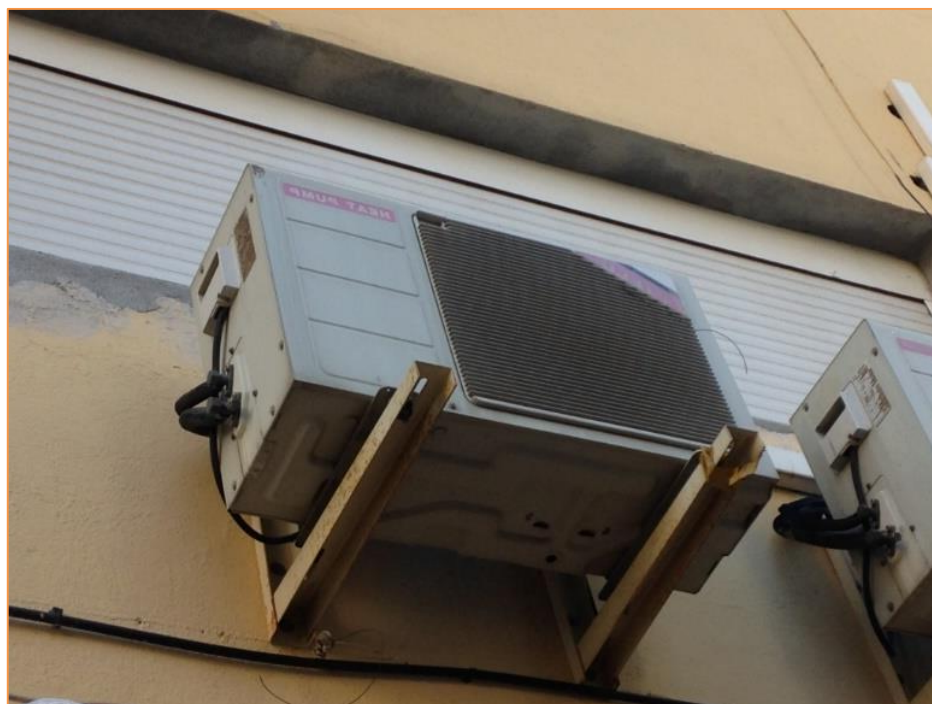
Fotografía 27. Unidades exteriores Splits Fachada
