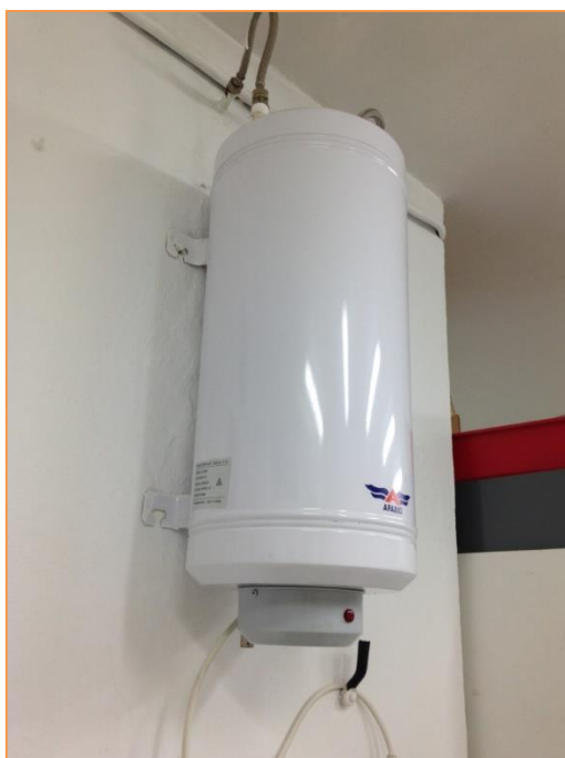
Fotografía 29. Termo acumulador eléctrico
