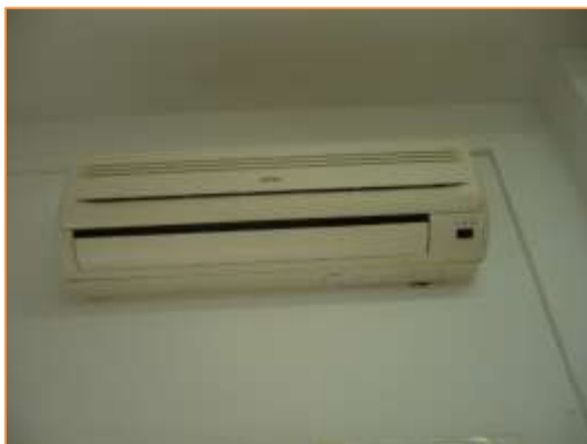
Imagen 18 Tipología de unidades interiores instaladas – Unidad de pared – Aula 1 y 2 - EPA
