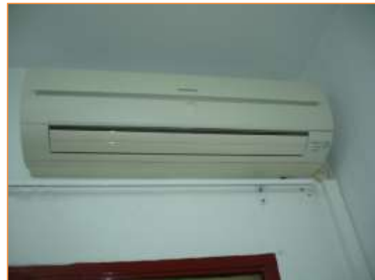
Imagen 14 Tipología de unidades interiores instaladas – Unidad de pared – Aula 4 – Fuera de uso
