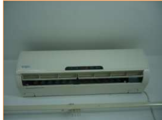
Imagen 17 Tipología de unidades interiores instaladas – Unidad de pared – Aula 7 – Fuera de uso
