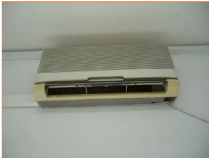
Imagen 19 Tipología de unidades interiores instaladas – Unidad de pared – Aula 3 – Fuera de uso
