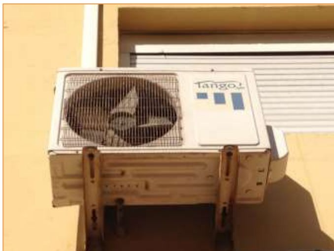
Imagen 9 Equipos de producción de frío y calor para climatización – Aula 7 – Fuera de uso
