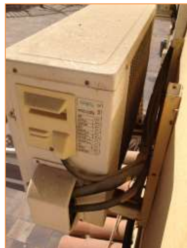
Imagen 9 Equipos de producción de frío y calor para climatización – Aula 7 – Fuera de uso
