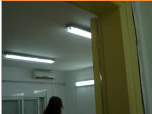
Imagen 17 Tipología de unidades interiores instaladas – Unidad de pared – Aula 7 – Fuera de uso
