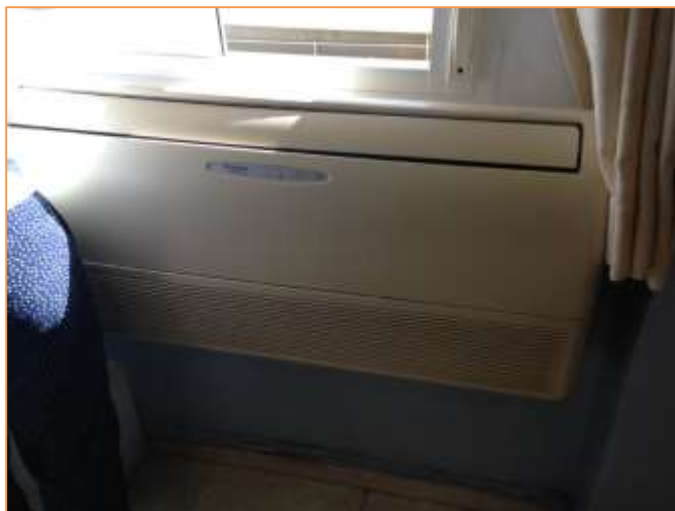
Imagen 15 Tipología de unidades interiores instaladas – Unidad de suelo – Oficinas
