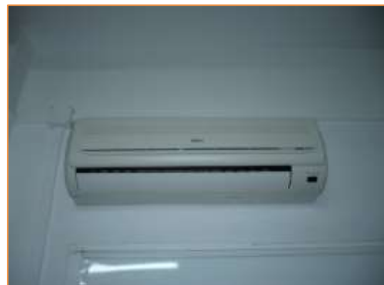
Imagen 18 Tipología de unidades interiores instaladas – Unidad de pared – Aula 1 y 2 - EPA
