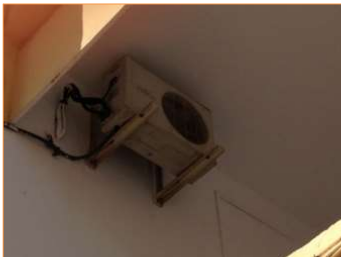
Imagen 12 Equipos de producción de frío y calor para climatización – Aula 3 – Fuera de uso
