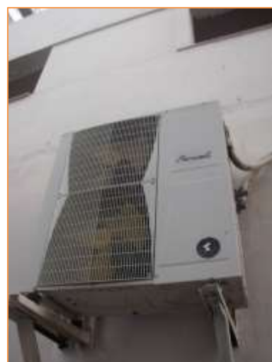
Imagen 6 Equipos de producción de frío y calor para climatización – Fachada NO – Climatización general
