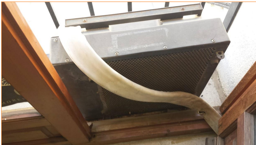
Fotografía 28. Deshumectadora tipo BdC – Instalaciones deportivas
