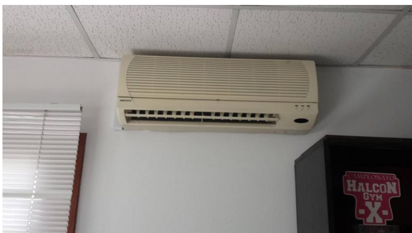
Imagen 18 Tipología de unidades interiores instaladas - De pared– Actividades deportivas – Planta 1ª
