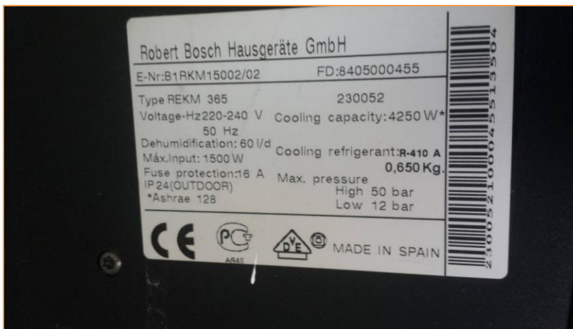
Imagen 10 Equipos de producción de frío y calor para climatización – Deshumectadora – Aula idiomas – Planta 1ª
