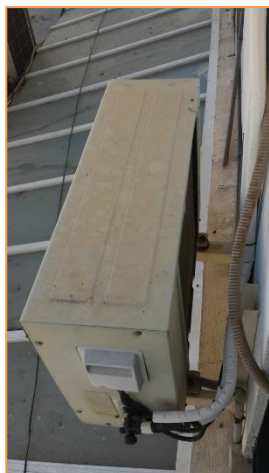
Imagen 11 Equipos de producción de frío y calor para climatización – Split 1x1– Actividades deportivas – Planta 1ª
