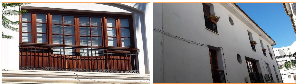
Imagen 3 Diferentes tipos de carpintería exterior
