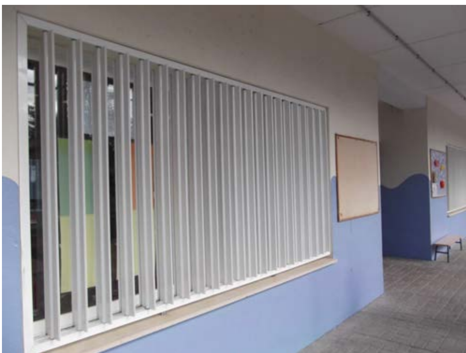
Fotografía 8. Protección Solar Módulo 1
