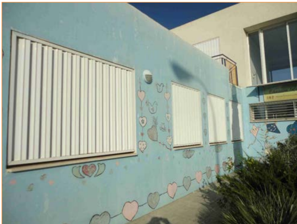
Fotografía 7. Protección Solar Edificio Principal
