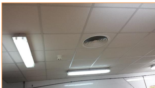
Imagen 8 Tipología de UTAs instaladas –Elementos de difusión de aire
