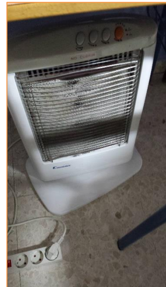
Imagen 7 Tipología de unidades interiores instaladas- Radiadores y convectores eléctricos de suelo
