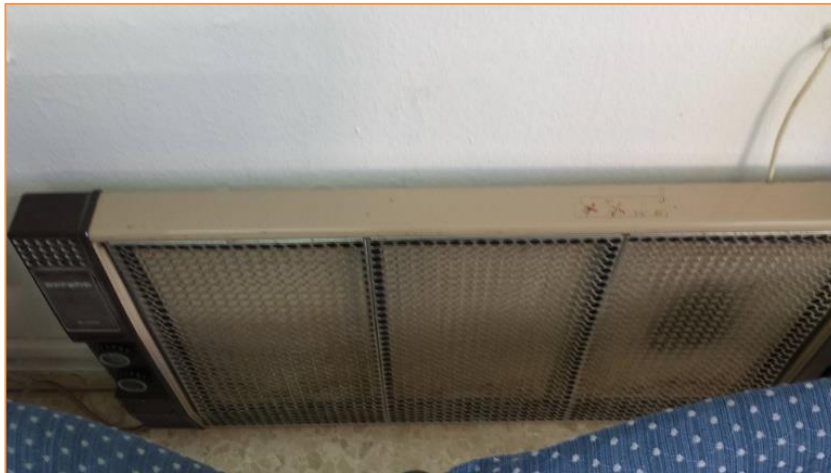
Imagen 6 Tipología de unidades interiores instaladas- Radiadores y convectores eléctricos de suelo
