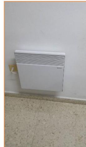
Imagen 6 Tipología de unidades interiores instaladas- Radiadores y convectores eléctricos de suelo
