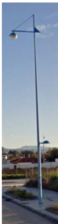
Imagen 16.- Columna con brazo (11m)
