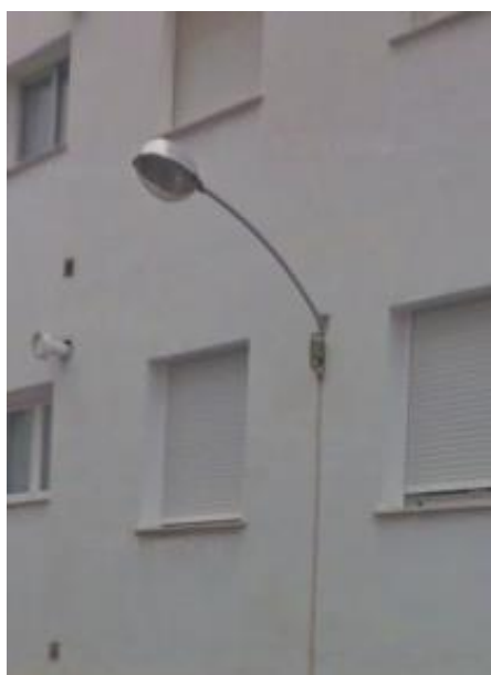
Imagen 17.- Brazo fijado en pared (6m)
