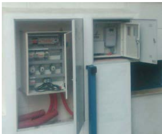
Imagen 8.- Módulo de medida electrónico en centro de mando (CM-001)
