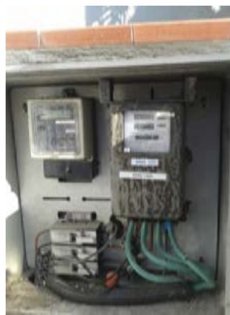
Imagen 9.- Módulo de medida electromagnético en centro de mando (CM-032)
