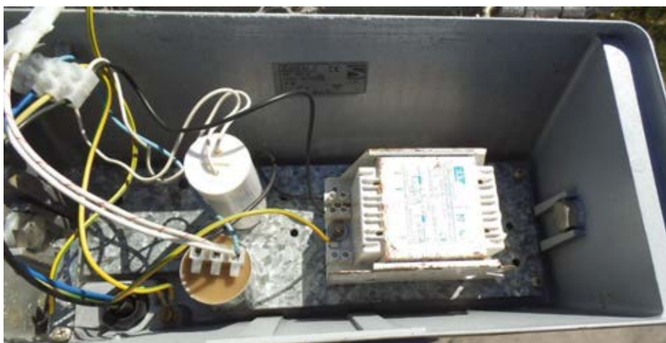
Imagen 12.- Balastro electromagnético
