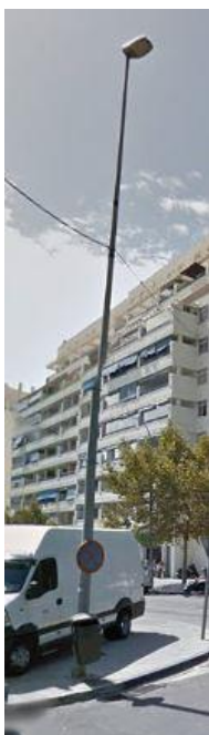
Imagen 13.- Columna metálica troncocónica (12 m)
