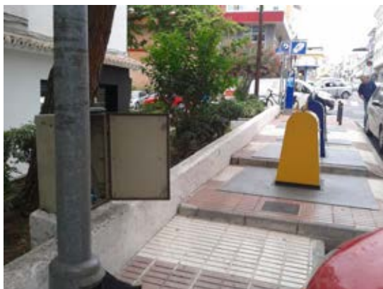
Imagen 1.- Centro de mando montado sobre zócalo (CM-308)
