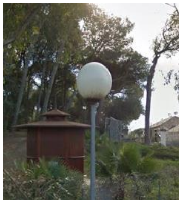
Imagen 24.- Luminaria de tipo esférica sin reflector (Globo Ler)
