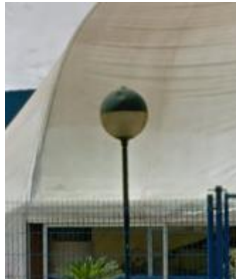
Imagen 25.- Luminaria de tipo esférica con reflector (Globo Lekr)
