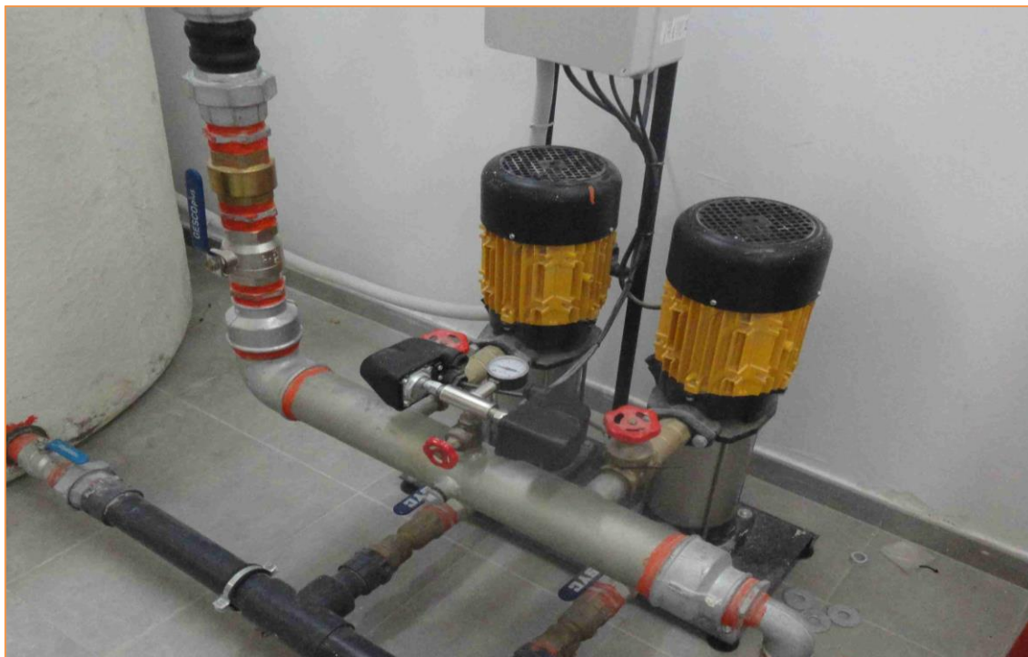
Fotografía 48. Bombas distribución ACS Sala de Máquinas
