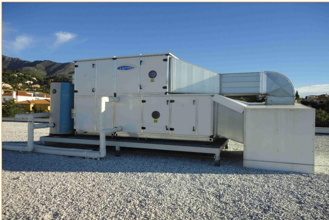
Fotografía 50. Climatizadora con acumulador en cubierta
