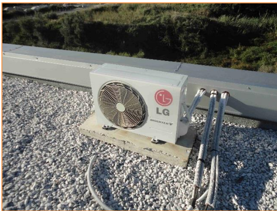
Imagen 6 Equipos de producción de frío y calor para climatización – Sistemas autónomos de expansión directa tipo BdC – Split 1x1
