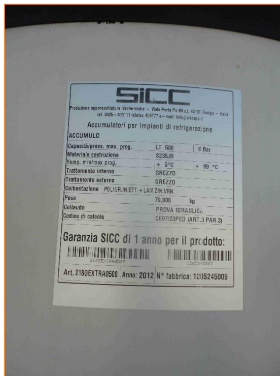
Imagen 10 Climatizadora y depósito de inercia
