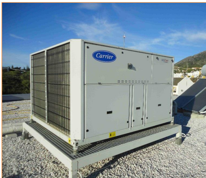
Imagen 7 Equipos de producción de frío y calor para climatización – Bomba de calor
