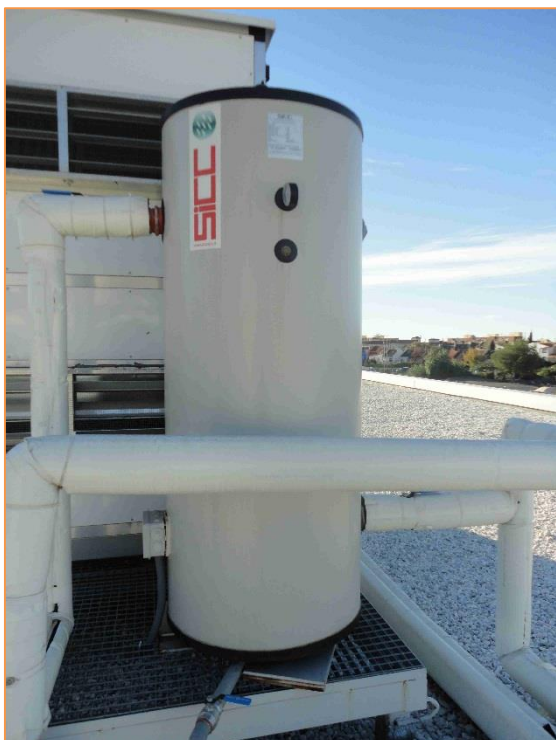
Imagen 10 Climatizadora y depósito de inercia
