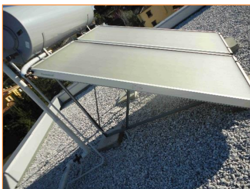
Imagen 4 Instalación solar para ACS
