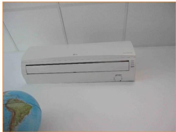
Imagen 6 Equipos de producción de frío y calor para climatización – Sistemas autónomos de expansión directa tipo BdC – Split 1x1
