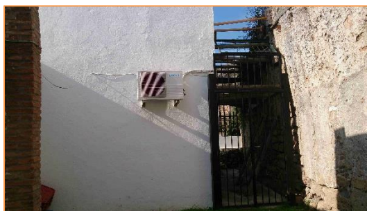
Imagen 5 Equipos de producción de frío y calor para climatización - Sistema autónomo de expansión directa tipo BdC – Split 1x1
