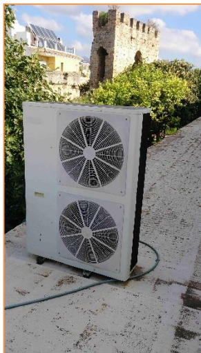
Imagen 4 Equipos de producción de frío y calor para climatización – Sistema autónomo de expansión directa tipo BdC – Split 1x1
