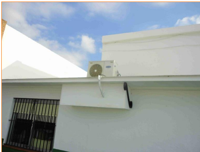
Imagen 4 Equipos de producción de frío y calor para climatización – Sistema autónomo de expansión directa tipo BdC – Split 1x1
