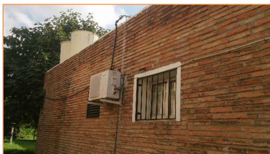
Imagen 5 Equipos de producción de frío y calor para climatización - Sistema autónomo de expansión directa tipo BdC – Split 1x1
