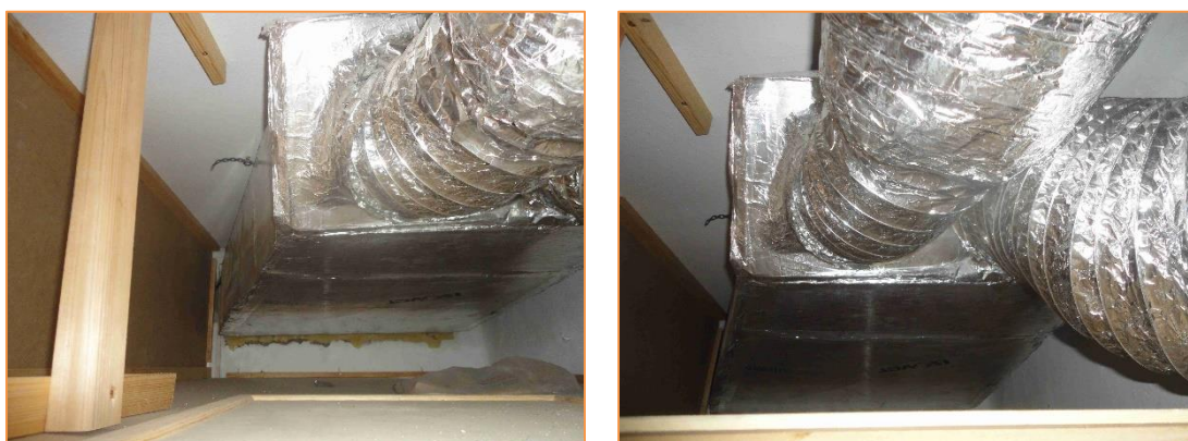
Imagen 6 Tipología de unidades interiores instaladas - Conductos
