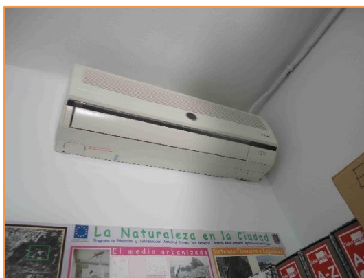
Imagen 7 Tipología de unidades interiores instaladas - Pared
