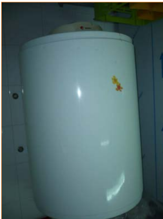
Fotografía 72. Termo acumulador eléctrico cocina
