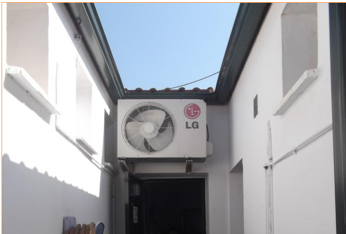
Fotografía 64. Unidades exteriores splits fachada patio primaria
