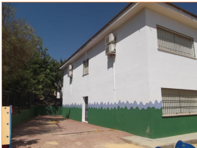
Imagen 6 Equipos de producción de frío y calor para climatización – Sistema autónomo de expansión directa tipo BdC – Split 1x1 - Módulo Infantil
