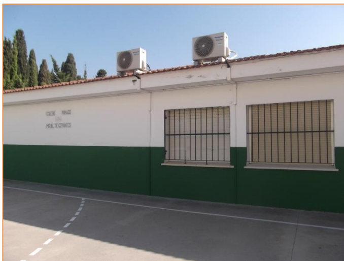
Imagen 8 Equipos de producción de frío y calor para climatización –Sistema autónomo de expansión directa tipo BdC – Split 1x1 - Módulo de Primaria 1
