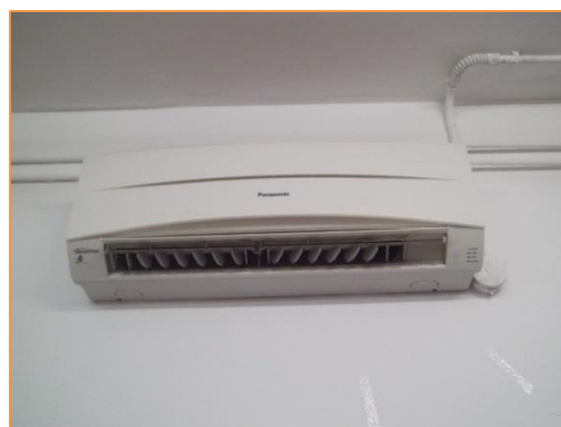
Imagen 17 Tipología de unidades interiores instaladas – De pared
