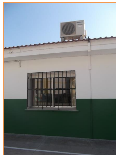
Imagen 8 Equipos de producción de frío y calor para climatización –Sistema autónomo de expansión directa tipo BdC – Split 1x1 - Módulo de Primaria 1
