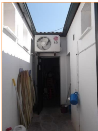
Imagen 10 Equipos de producción de frío y calor para climatización – Sistema autónomo de expansión directa tipo BdC – Split 1x1 – Módulo de Primaria 1
