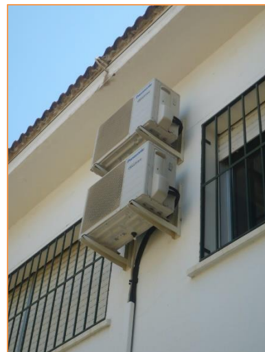
Imagen 6 Equipos de producción de frío y calor para climatización – Sistema autónomo de expansión directa tipo BdC – Split 1x1 - Módulo Infantil
