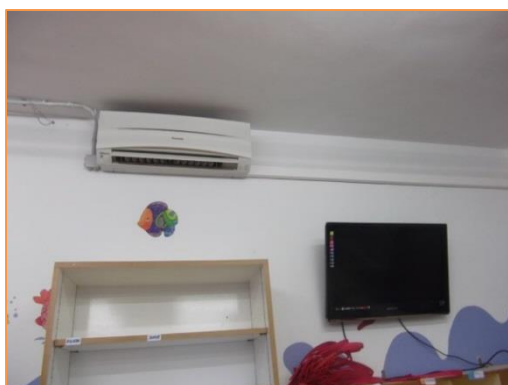
Imagen 17 Tipología de unidades interiores instaladas – De pared
