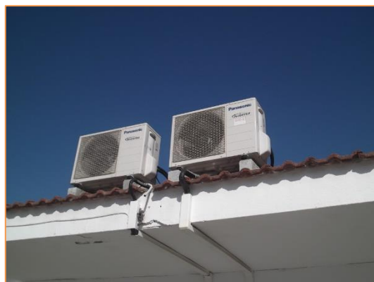
Imagen 9 Equipos de producción de frío y calor para climatización – Sistema autónomo de expansión directa tipo BdC – Split 1x1 – Módulo de Primaria 1
