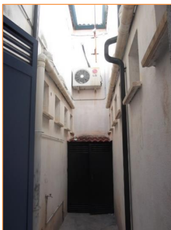
Imagen 15 Equipos de producción de frío y calor para climatización – Sistema autónomo de expansión directa tipo BdC – Split 1x1 – Módulo de Primaria 2
