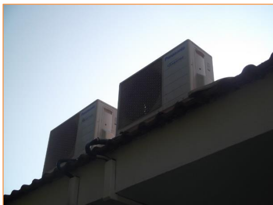
Imagen 9 Equipos de producción de frío y calor para climatización – Sistema autónomo de expansión directa tipo BdC – Split 1x1 – Módulo de Primaria 1
