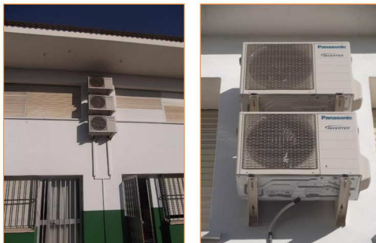
Imagen 14 Equipos de producción de frío y calor para climatización– Sistema autónomo de expansión directa tipo BdC – Split 1x1 – Módulo de Primaria 2
