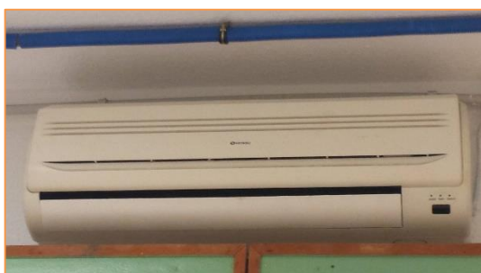
Imagen 20 Tipología de unidades interiores instaladas – De pared
