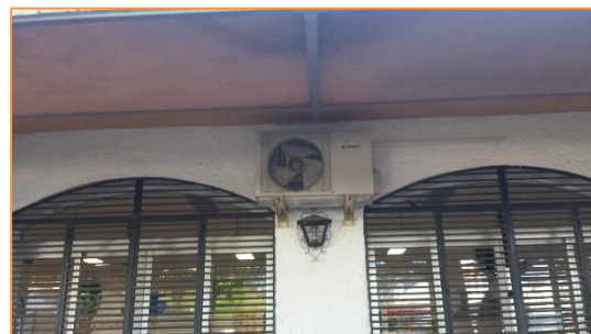
Imagen 15 Equipos de producción de frío y calor para climatización - Edificio sala de profesores
