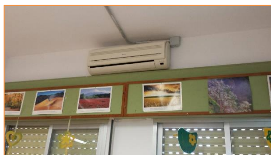
Imagen 20 Tipología de unidades interiores instaladas – De pared
