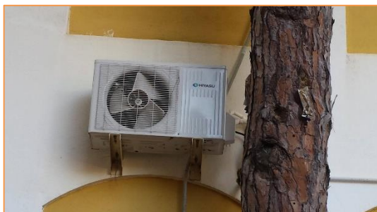
Imagen 11 Equipos de producción de frío y calor para climatización - Edificio principal
