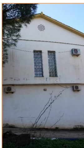
Imagen 17 Equipos de producción de frío y calor para climatización – Edificio comedor
