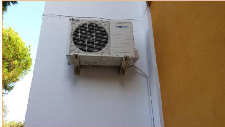
Imagen 13 Equipos de producción de frío y calor para climatización - Edificio principal
