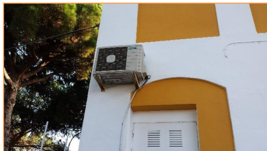
Imagen 12 Equipos de producción de frío y calor para climatización - Edificio principal
