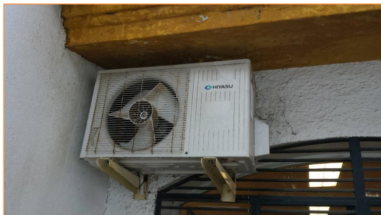
Imagen 16 Equipos de producción de frío y calor para climatización - Edificio sala de profesores
