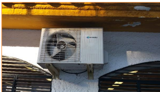
Imagen 15 Equipos de producción de frío y calor para climatización - Edificio sala de profesores
