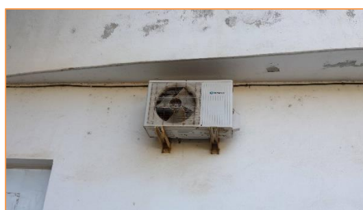
Imagen 18 Equipos de producción de frío y calor para climatización - Edificio comedor
