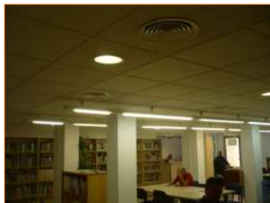
Imagen 7 Tipología de unidades interiores instaladas – Regulación y elementos de difusión (rotacionales)
