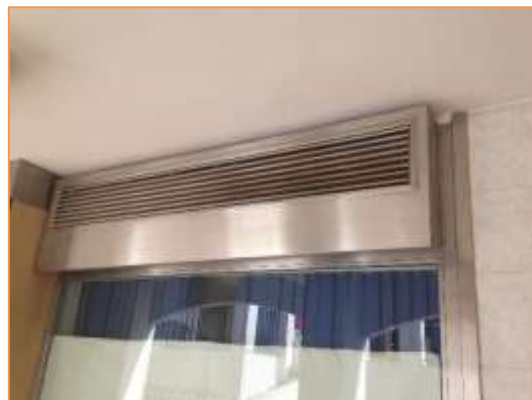
Imagen 4 Equipos de producción de frío y calor para climatización – Unidades exteriores - En falso techo y de condensación en fachada principal
