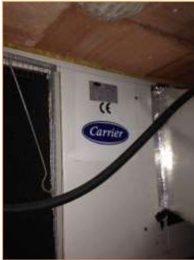
Imagen 6 Tipología de unidades interiores instaladas – Unidades de conductos
