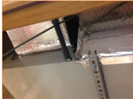
Imagen 5 Tipología de unidades interiores instaladas – Unidades de conductos
