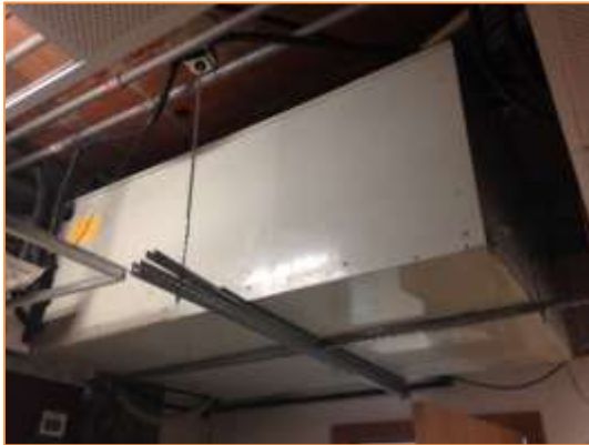
Imagen 5 Tipología de unidades interiores instaladas – Unidades de conductos
