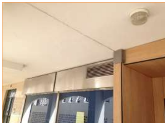
Imagen 4 Equipos de producción de frío y calor para climatización – Unidades exteriores - En falso techo y de condensación en fachada principal
