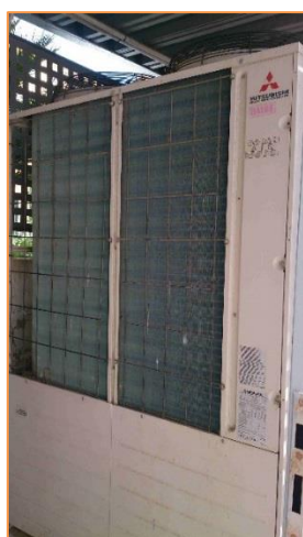
Fotografía 19. Equipo frío Calor y calor para climatización – Bomba de calor – Sistema VRV
