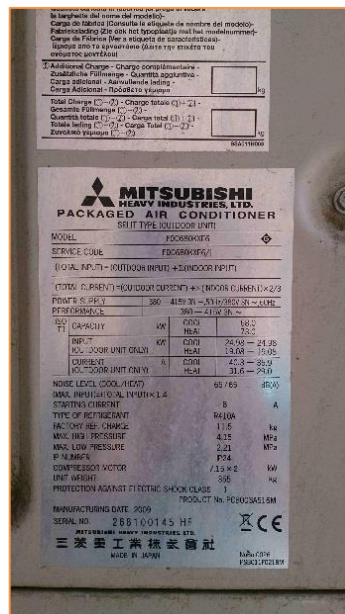
Imagen 5 Equipos de producción de frío y calor para climatización – Bomba de calor – Sistema VRV
