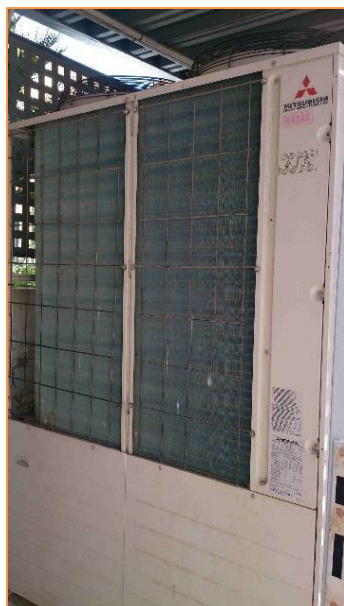
Imagen 5 Equipos de producción de frío y calor para climatización – Bomba de calor – Sistema VRV
