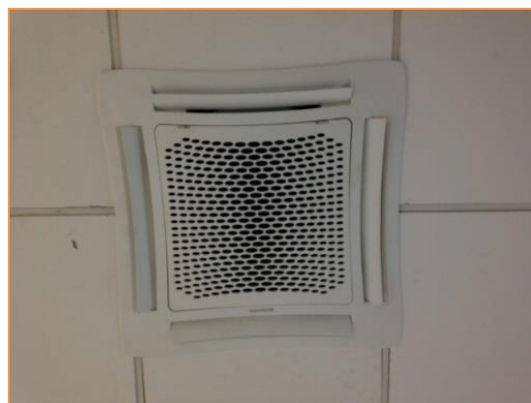
Imagen 8 Tipología de fancoils instalados - Cassette
