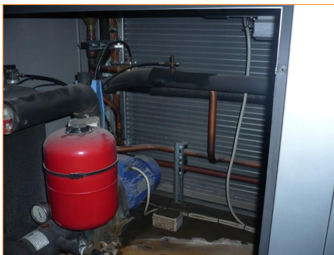
Imagen 5 Equipos de producción de frío y calor para climatización – Bomba de calor – Sala de máquinas 4
