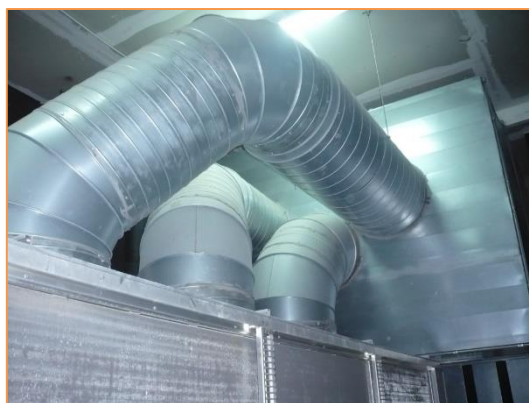
Imagen 4 Equipos de producción de frío y calor para climatización – Bomba de calor – Sala de máquinas 3
