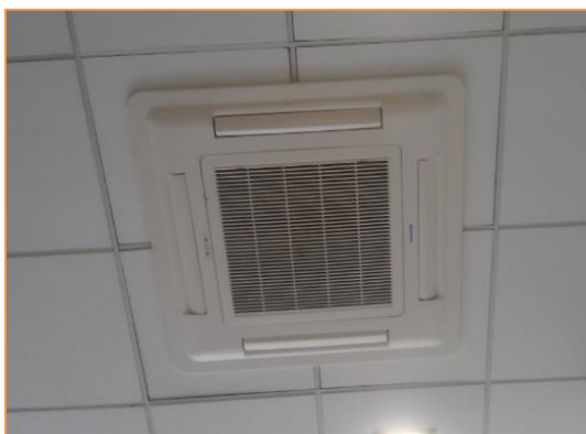
Imagen 8 Tipología de fancoils instalados - Cassette
