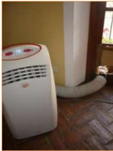
Imagen 7 Tipología de unidades de expansión directa instaladas – BdC deshumectadora portátil – Despacho 3
