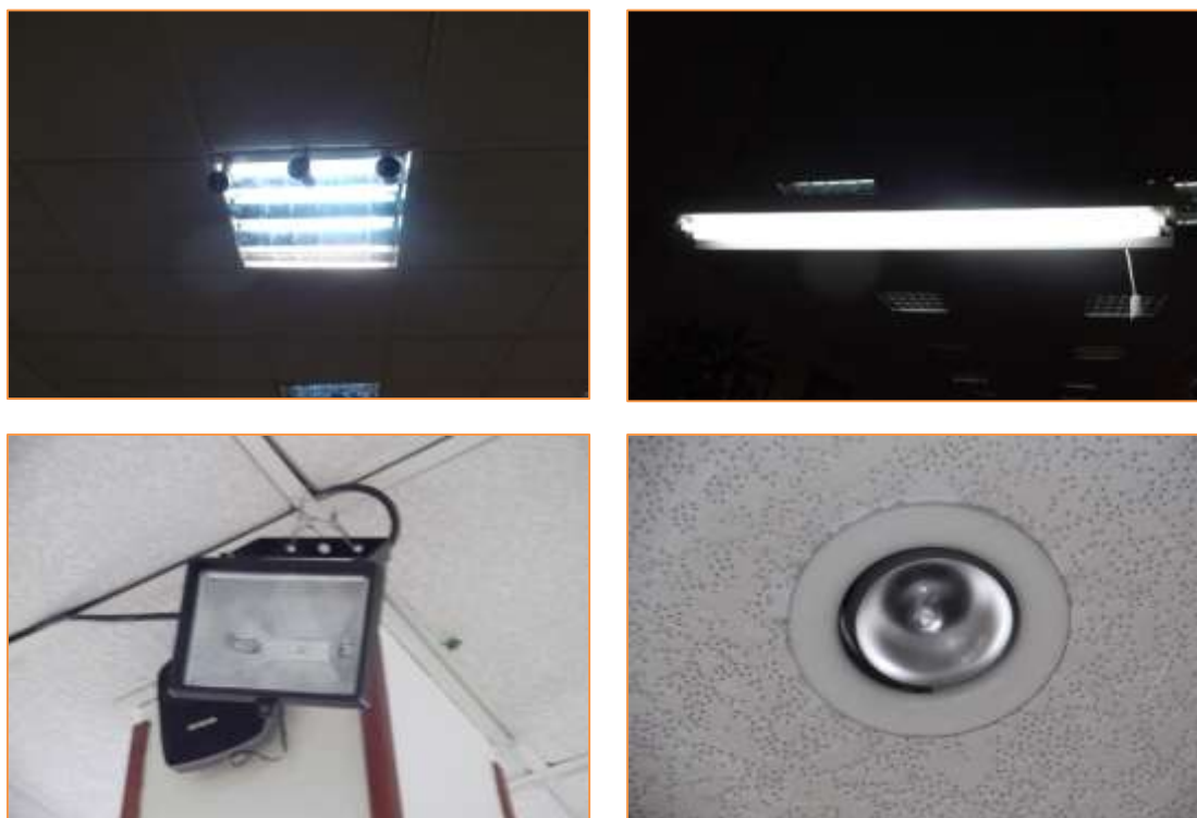
Imagen 9 Tipos de luminarias instaladas
