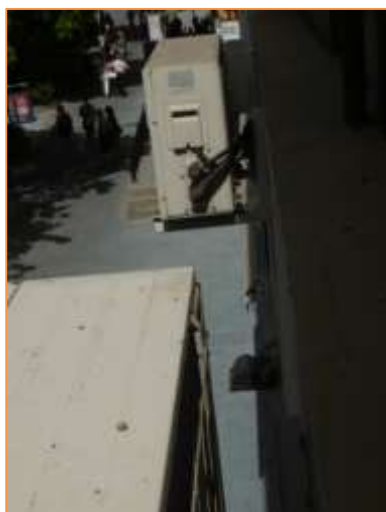
Imagen 6 Equipos de producción de frío y calor para climatización – Taller 2
