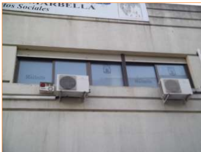
Imagen 6 Equipos de producción de frío y calor para climatización – Taller 2
