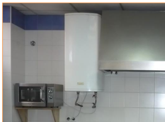
Fotografía 48. Termos eléctricos
