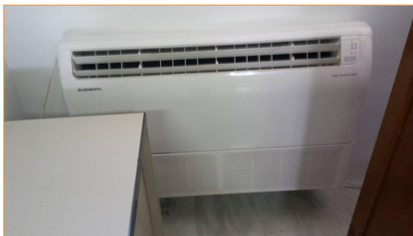
Imagen 12 Tipología de unidades interiores instaladas - Sistema autónomo de expansión directa – MultiSplit tipo suelo
