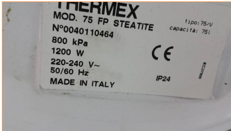
Imagen 8 Termos acumuladores eléctricos – Guardería – Cocina
