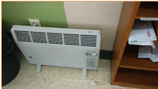
Imagen 8 Tipología de unidades interiores instaladas- Radiadores eléctricos
