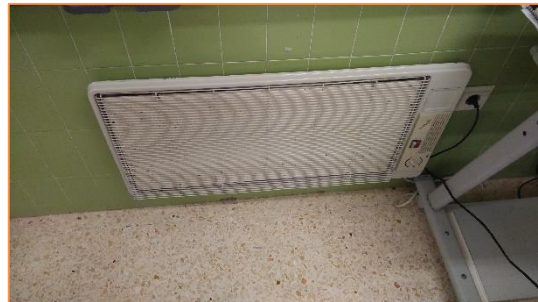
Imagen 8 Tipología de unidades interiores instaladas- Radiadores eléctricos
