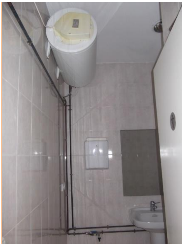
Fotografía 22. Termo acumulador eléctrico
