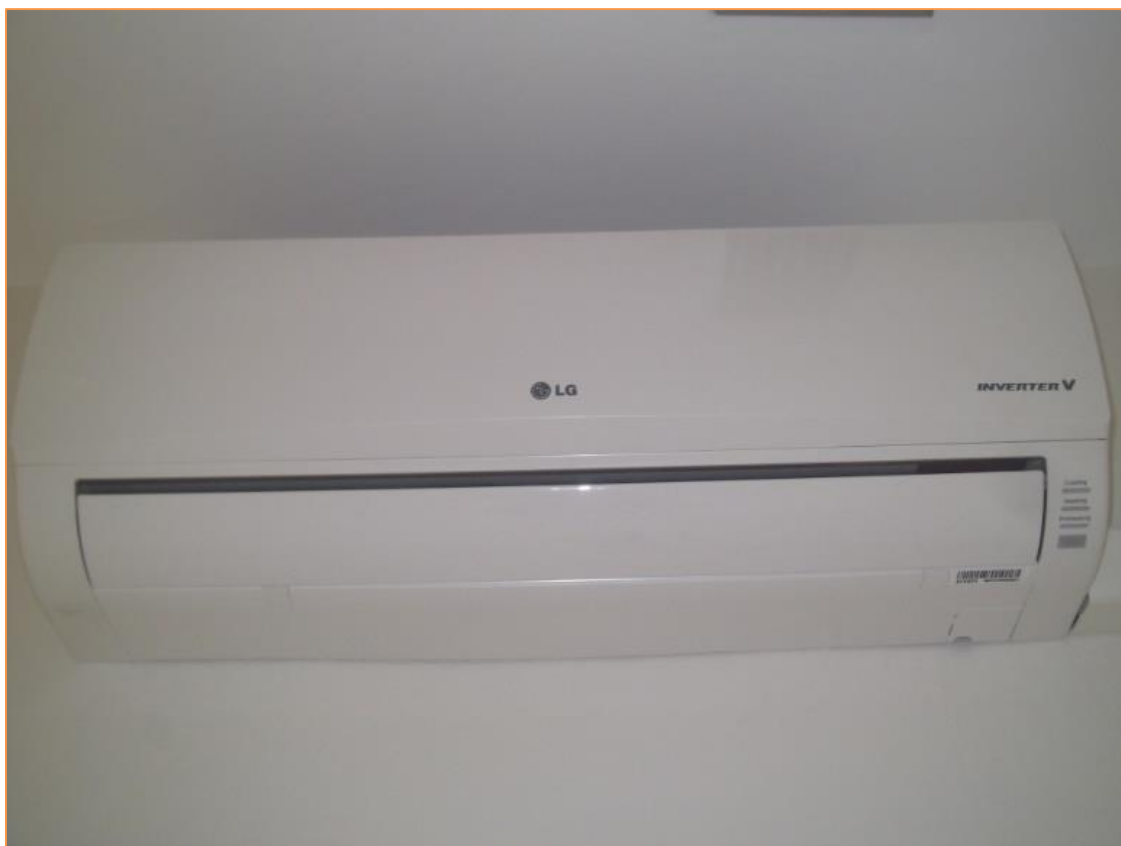
Fotografía 20 Unidades interiores tipo Split de pared
