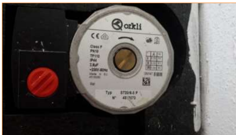
Imagen 5 Grupos de bombeo – Primario solar térmica y recirculación ACS
