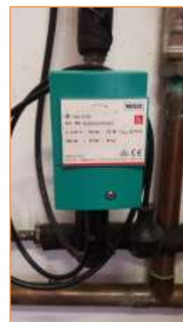
Imagen 5 Grupos de bombeo – Primario solar térmica y recirculación ACS
