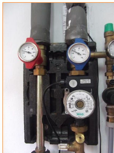
Fotografía 33. Grupos de bombeo – Primario circuito solar
