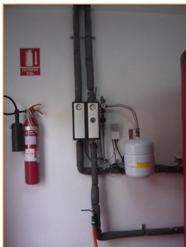
Fotografía 33. Grupos de bombeo – Primario circuito solar
