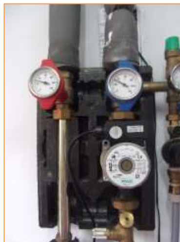
Imagen 8 Grupos de bombeo – Primario circuito solar
