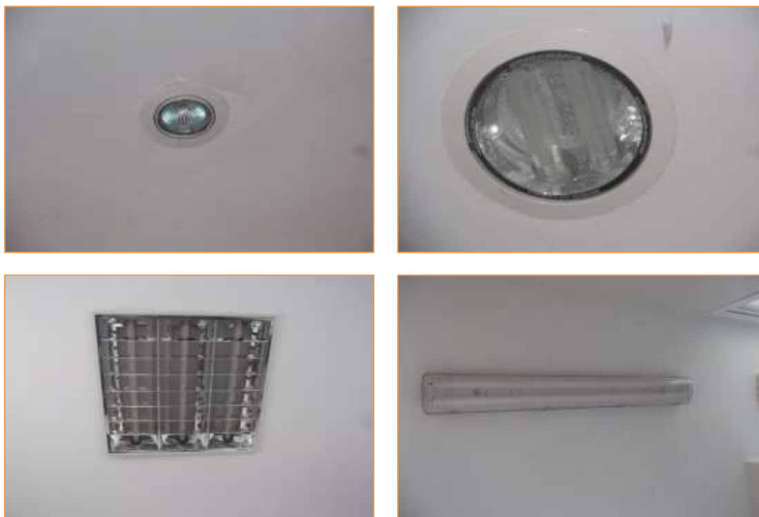
Imagen 11 Tipos de luminarias instaladas
