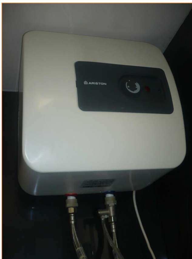
Fotografía 48. Termo acumulador eléctrico Aseo
