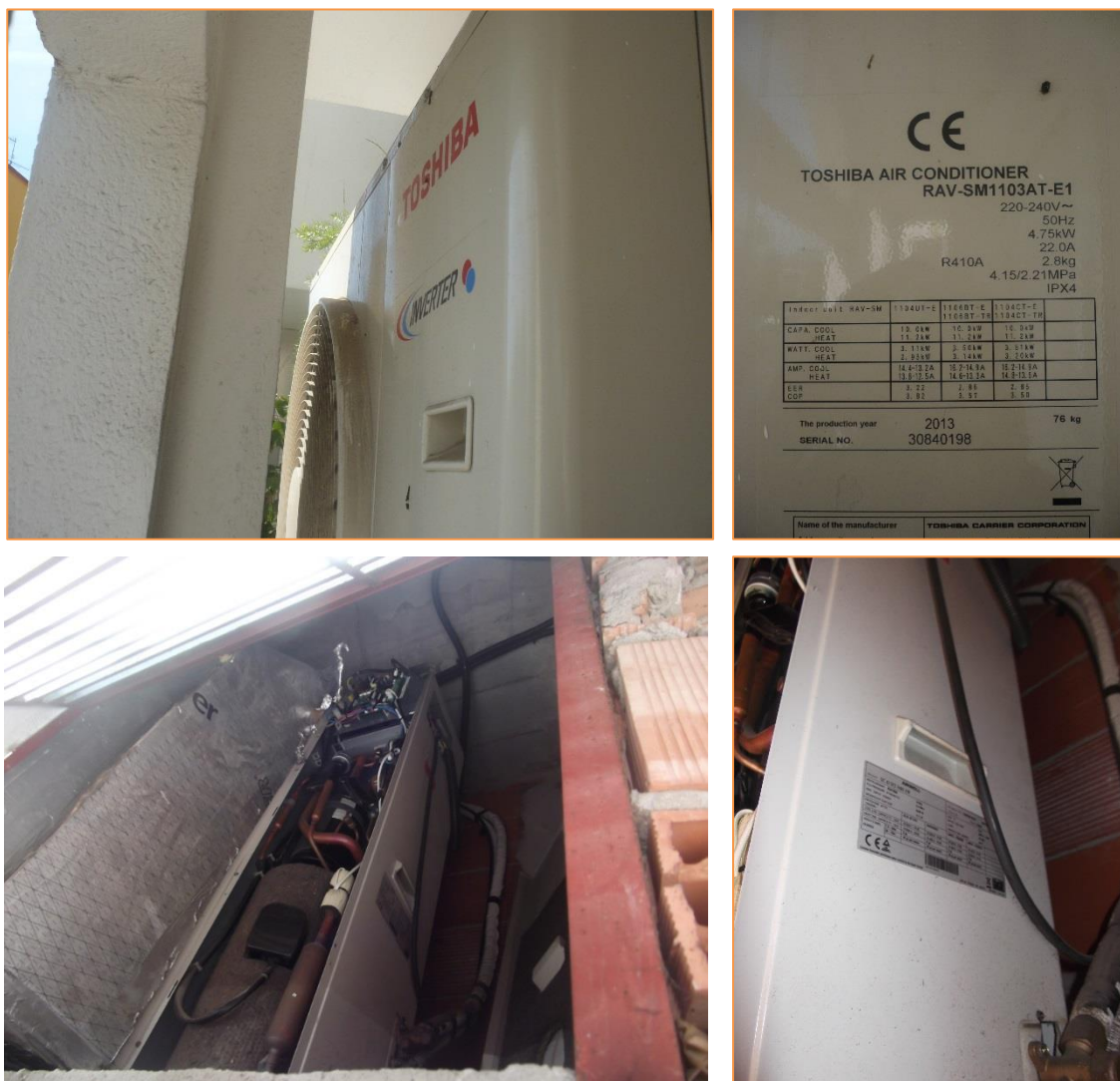
Imagen 5 Equipos de producción de frío y calor para climatización
