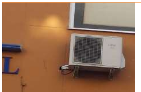
Imagen 5 Equipo de expansión directa tipo Split-Fachada SO1
