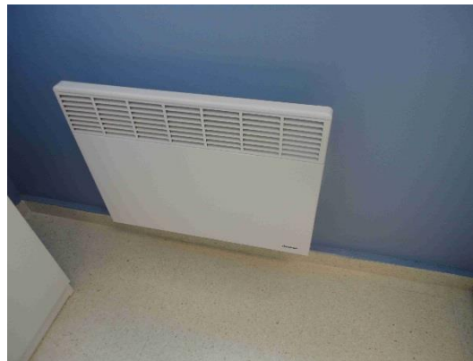
Imagen 12 Tipología de convectores instalados
