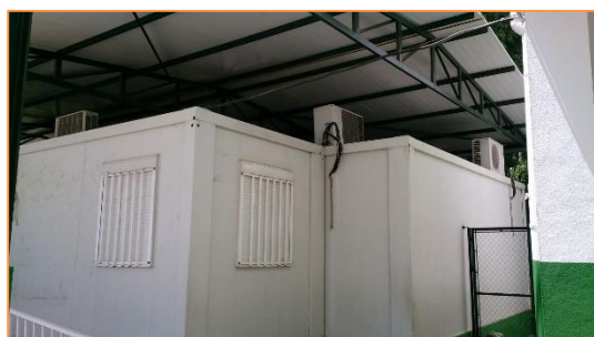
Imagen 7 Equipos de producción de frío y calor para climatización – Edificio prefabricado – Sistemas autónomos de expansión directa tipo BdC (Split 1x1)
