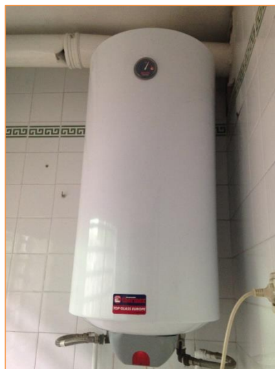
Imagen 4 Termos acumuladores eléctricos –Servicio A.E. y vivienda conserje
