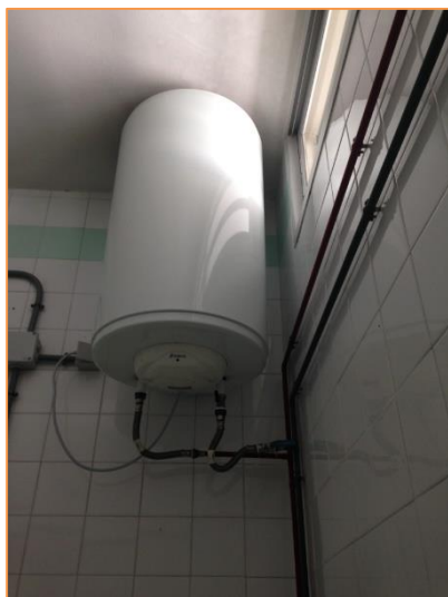
Imagen 4 Termos acumuladores eléctricos –Servicio A.E. y vivienda conserje
