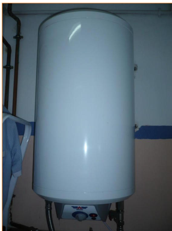
Fotografía 54. Termo acumulador eléctrico almacén limpiadoras
