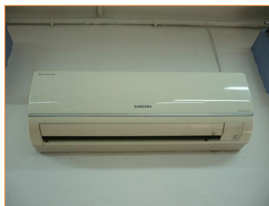
Imagen 11 Tipología de unidades interiores instaladas – Split 1x1 de pared
