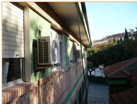
Imagen 10 Equipos de producción de frío y calor para climatización – Sistema autónomo de expansión directa tipo BdC – Split 1x1
