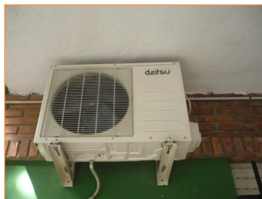
Imagen 8 Equipos de producción de frío y calor para climatización – Sistema autónomo de expansión directa tipo BdC – Split 1x1
