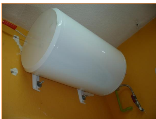
Imagen 4 Termos acumuladores eléctricos - Baño
