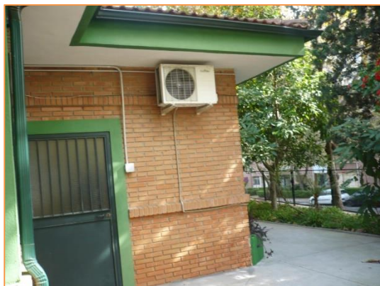
Imagen 10 Equipos de producción de frío y calor para climatización – Sistema autónomo de expansión directa tipo BdC – Split 1x1
