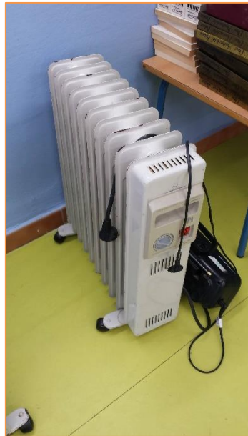
Imagen 5 Tipología de unidades interiores instaladas- Radiadores eléctricos
