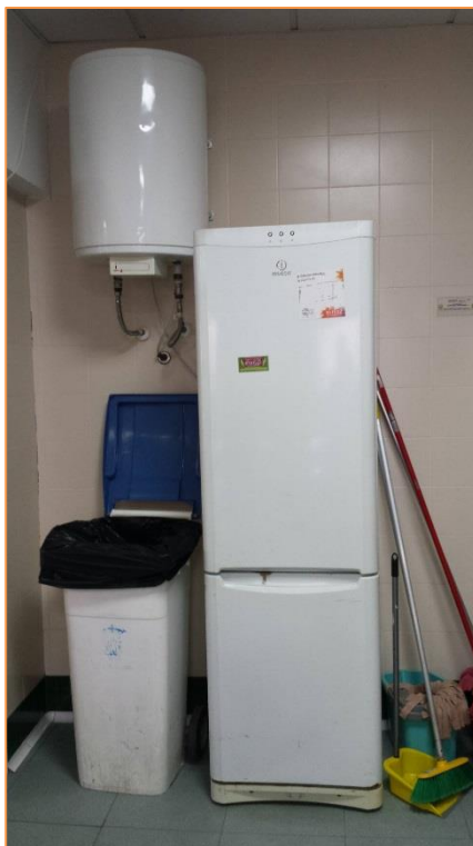
Fotografía 72. Termo acumulador eléctrico Cocina
