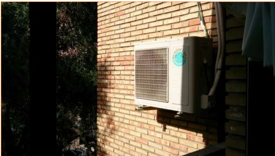
Fotografía 22. Unidades exteriores tipo split
