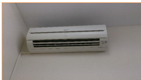
Imagen 5 Equipos de producción de frío y calor para climatización – Sistemas autónomos de expansión directa tipo Bdc (Split 1x1)
