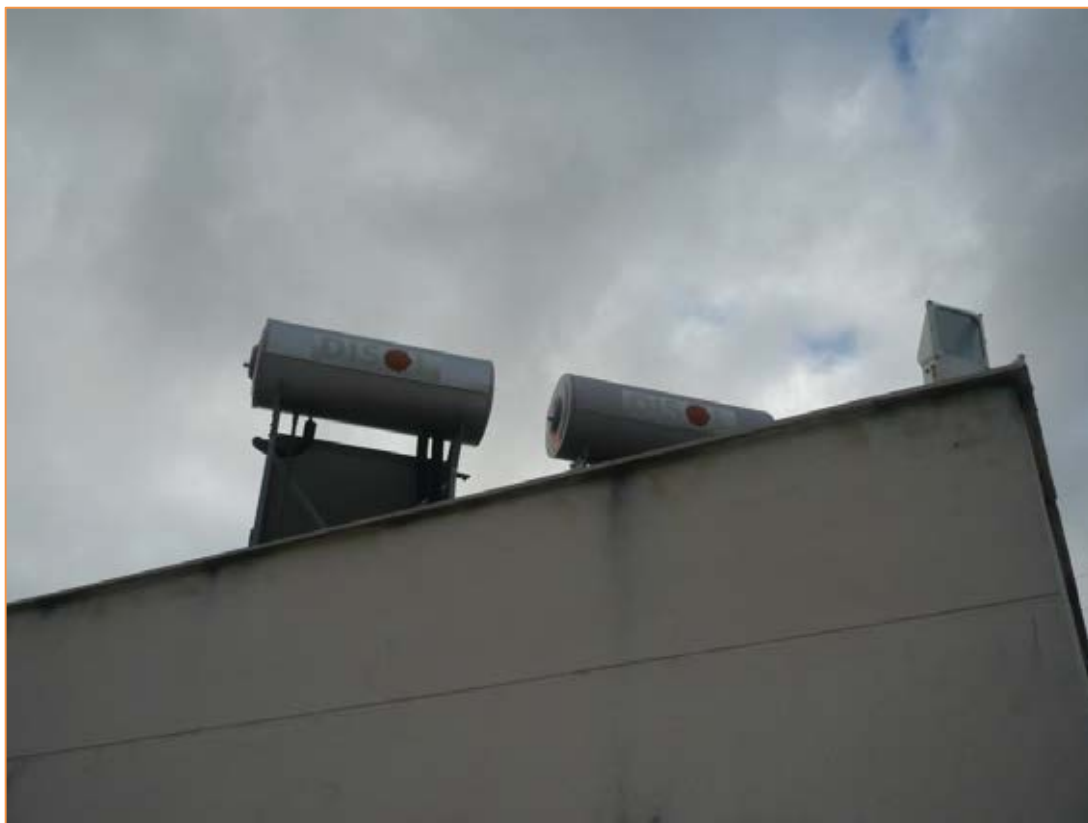
Fotografía 48. Captadores solares Cubierta
