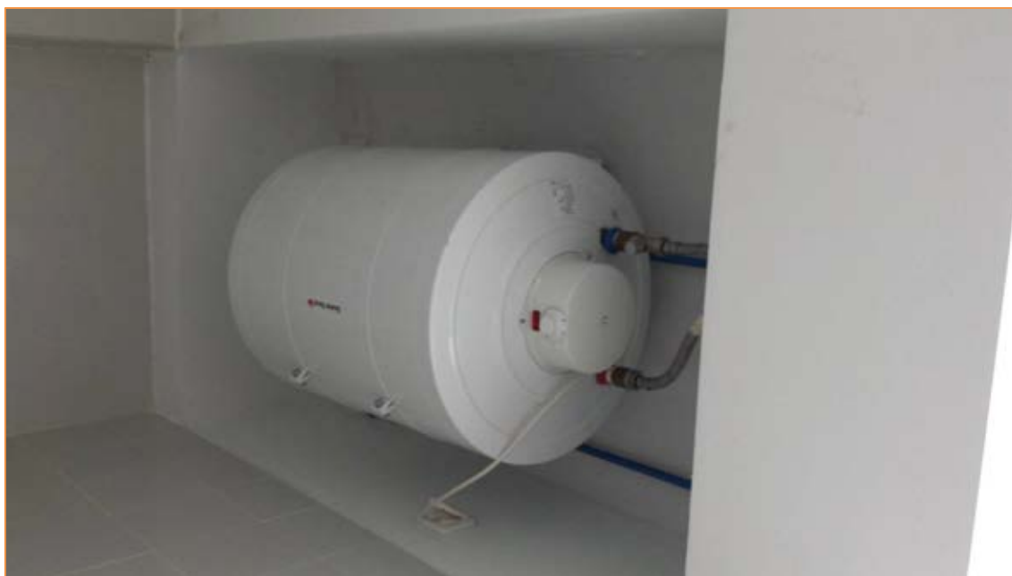
Fotografía 79. Termo acumulador eléctrico Cocina
