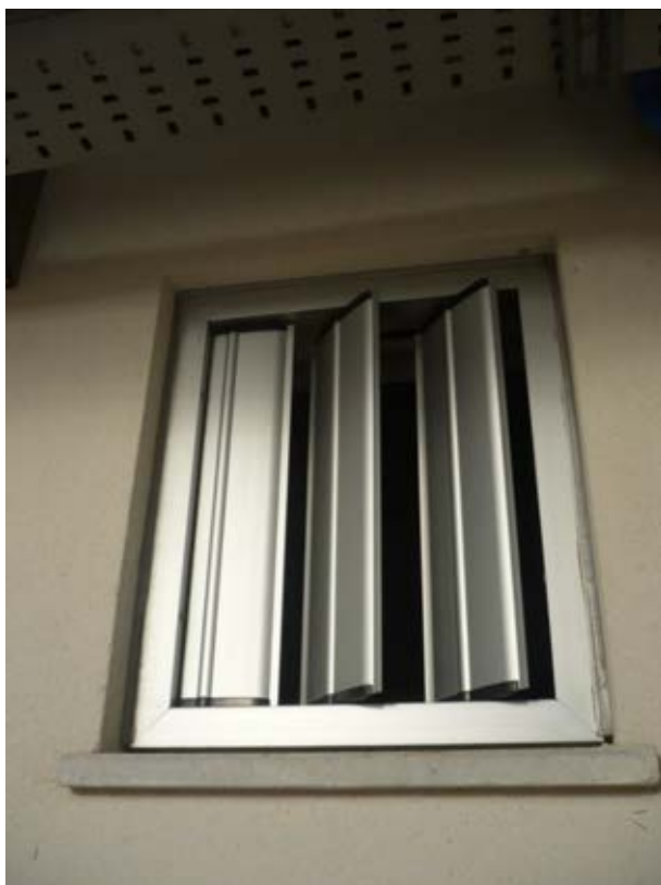
Fotografía 8. Protección solar exterior
