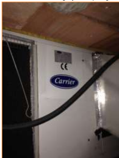
Fotografía 2 Tipología de unidades interiores instaladas – Unidades de conductos
