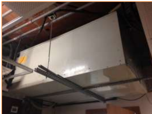
Fotografía 1 Tipología de unidades interiores instaladas – Unidades de conductos
