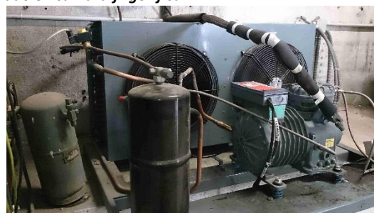
Imagen 5 Equipo frigorífico instalado en cámara frigorífica 2
