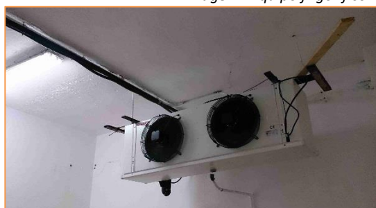
Imagen 5 Equipo frigorífico instalado en cámara frigorífica 2
