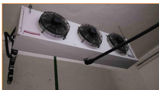
Imagen 4 Equipo frigorífico instalado en cámara frigorífica 1
