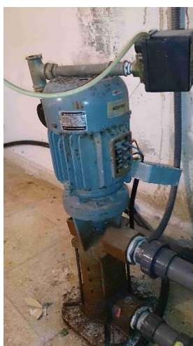
Imagen 6 Grupo de bombeo para presión de agua sanitaria
