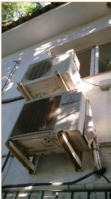
Fotografía 51. Unidad exterior Split Fachada
