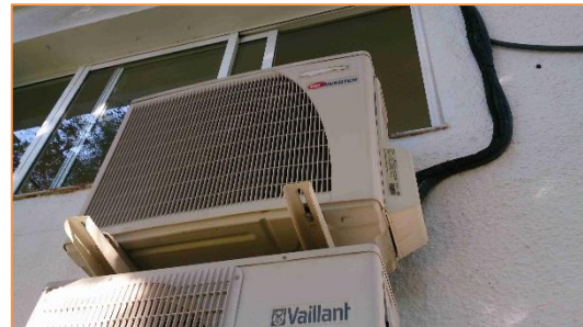
Imagen 4 Equipos de producción de frío y calor para climatización
