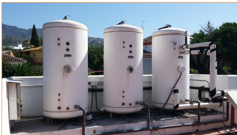
Imagen 6 Instalación solar térmica – Depósitos de acumulación solar (1.000 litros) y circuito primario solar
