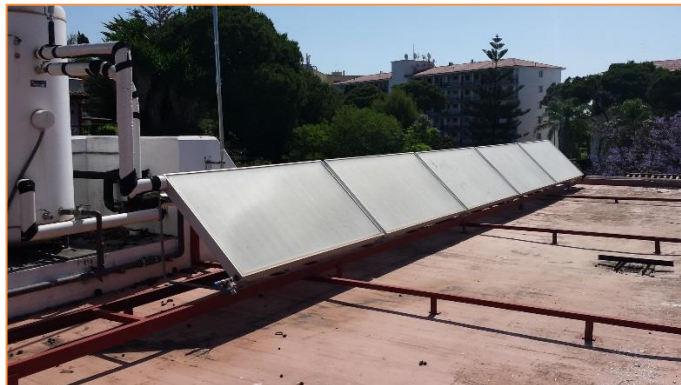
Imagen 4 Instalación solar térmica – Captadores
