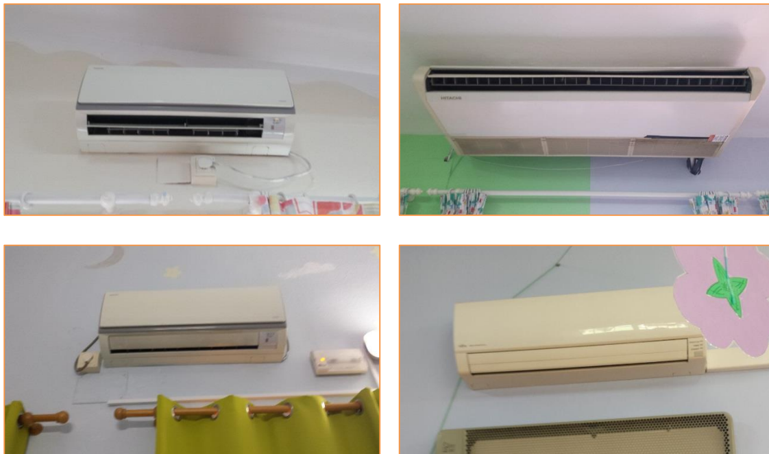
Imagen 9 Tipología de unidades interiores instaladas
