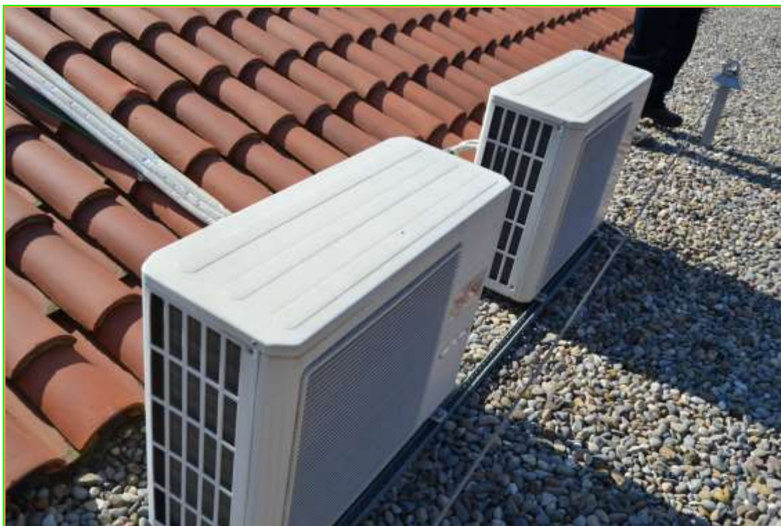
Fotografía 25. Unidades exteriores Splits Cubierta
