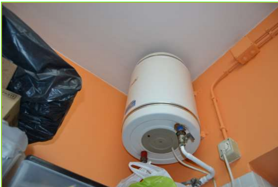
Fotografía 31. Termo acumulador eléctrico Aseo Aula P3
