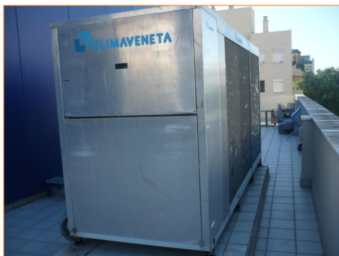
Imagen 8 Equipos de producción de frío y calor para climatización – Tipo1
