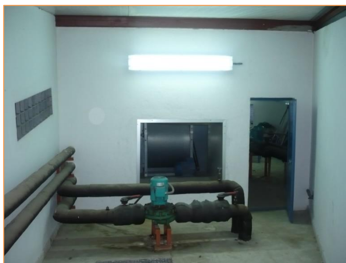
Imagen 14 Grupos de bombeo – Secundario calor-Climatizadora
