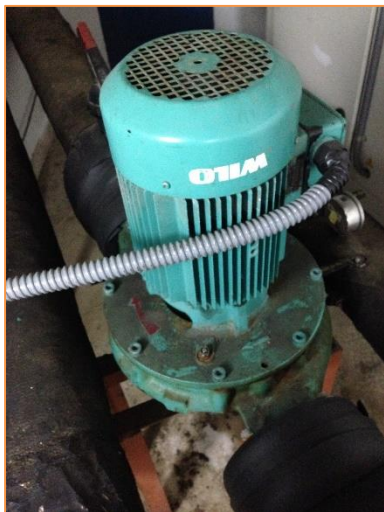
Imagen 15 Grupos de bombeo – Secundario calor – Climatizadora
