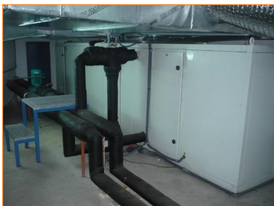
Imagen 21 Tipología de UTAs instaladas – Tipo 1
