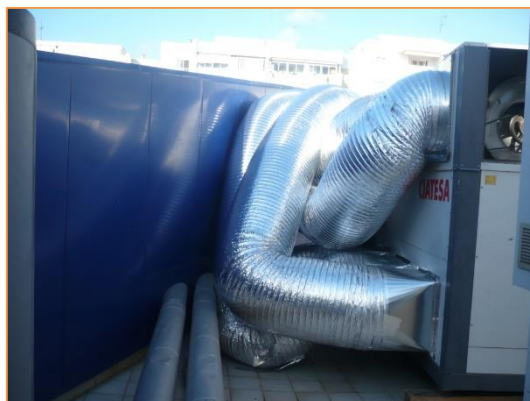
Imagen 20 Tipología de UTAs instaladas – Rooftop solo frío
