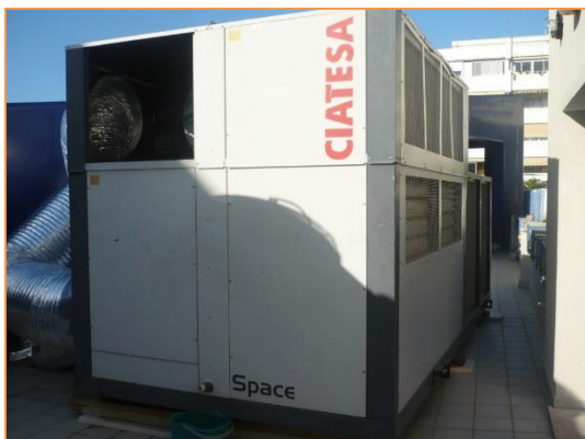
Imagen 20 Tipología de UTAs instaladas – Rooftop solo frío
