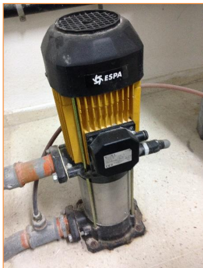
Imagen 16 Grupos de bombeo – Primario producción de frío
