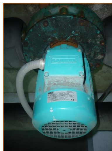
Imagen 14 Grupos de bombeo – Secundario calor-Climatizadora
