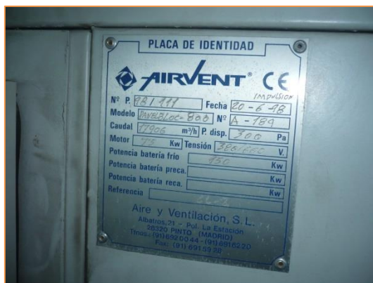
Imagen 21 Tipología de UTAs instaladas – Tipo 1
