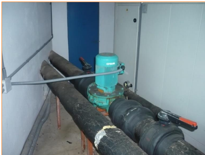
Imagen 15 Grupos de bombeo – Secundario calor – Climatizadora
