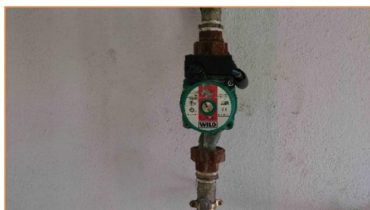
Imagen 13 Grupos de bombeo – Bomba recirculación ACS
