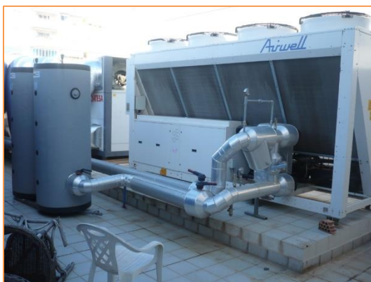
Imagen 10 Equipos de producción de frío y calor para climatización – Tipo 3
