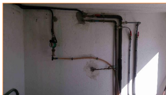
Imagen 13 Grupos de bombeo – Bomba recirculación ACS
