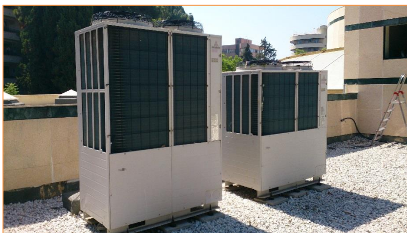
Fotografía 70 Unidades exteriores Splits Cubierta – Unidades VRV
