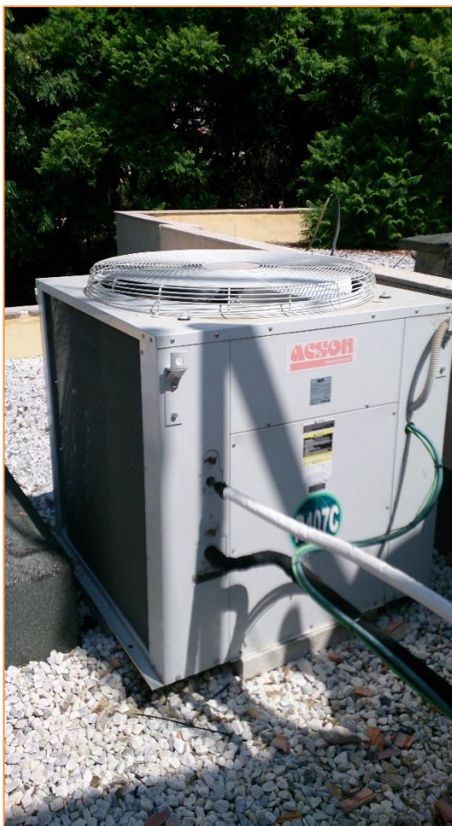
Fotografía 69. Unidades exteriores Splits Cubierta – Unidades multisplit
