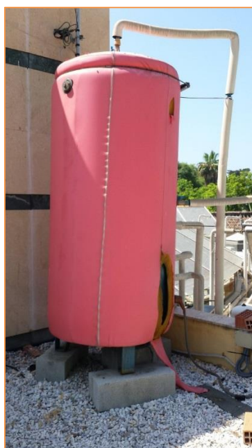
Fotografía 68. Depósito solar térmica
