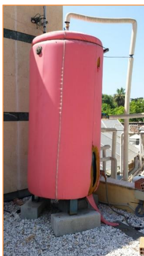
Imagen 6 Instalación solar térmica 1 – Depósito de acumulación solar (1.500 litros) y disipador térmico
