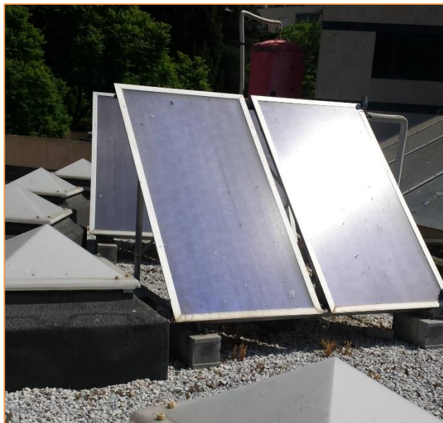
Imagen 4 Instalación solar térmica 1 – Captadores
