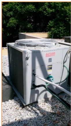
Imagen 7 Equipos de producción de frío y calor para climatización
